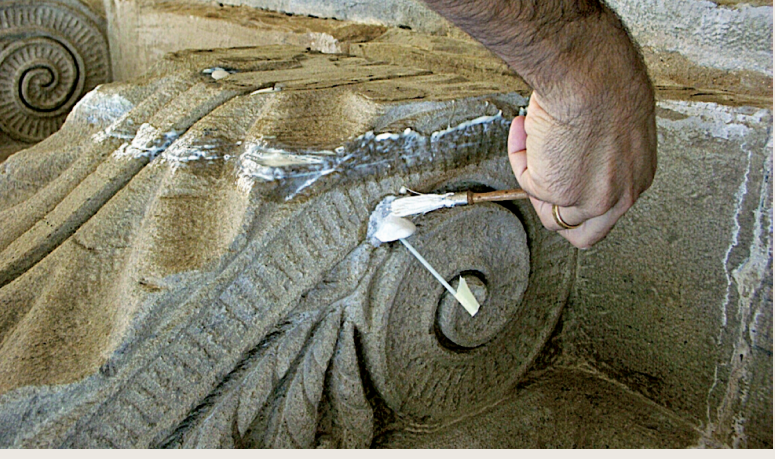
Il consolidamento della pietra è avvenuto tramite iniezioni con resina epossidica e in alcuni casi, per le parti distaccate di maggiori dimensioni, si è effettuato l'inserimento di alcuni perni in vetroresina per raggiungere una maggiore sicurezza di tenuta.
