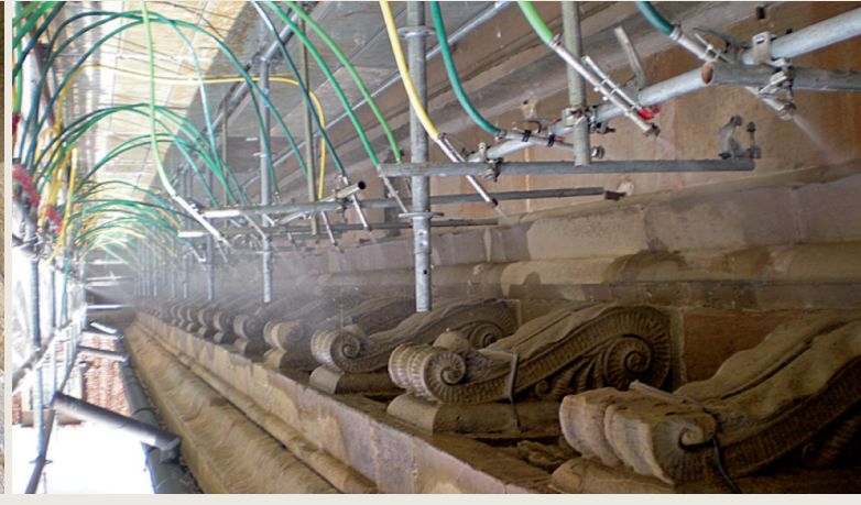
Dopo il preconsolidamento, e la rimozione dei depositi di polvere e delle piccole scaglie decese con pennelli e spazzole in setola morbida e con aspiratori, si è proceduto alla pittura della superficie con acqua nebulizzata a bassa pressione.
