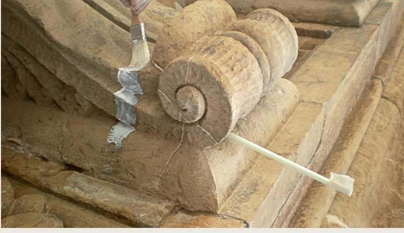
Il consolidamento della pietra è avvenuto tramite iniezioni con resina epossidica e in alcuni casi, per le parti distaccate di maggiori dimensioni, si è effettuato l'inserimento di alcuni perni in vetroresina per raggiungere una maggiore sicurezza di tenuta.
