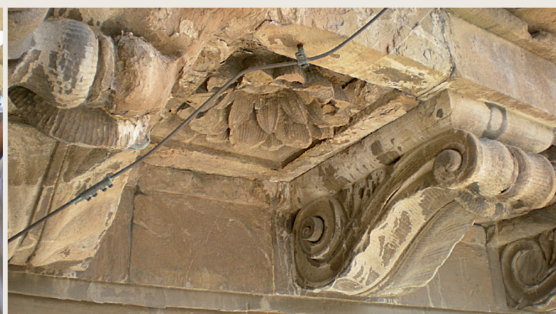
Fase finale di realizzazione della protezione superficiale a pennello con perfluoropolietteri ed un particolare dopo il restauro.
