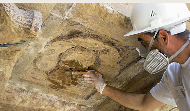
Fase finale di realizzazione della protezione superficiale a pennello con perfluoropolietteri ed un particolare dopo il restauro.
