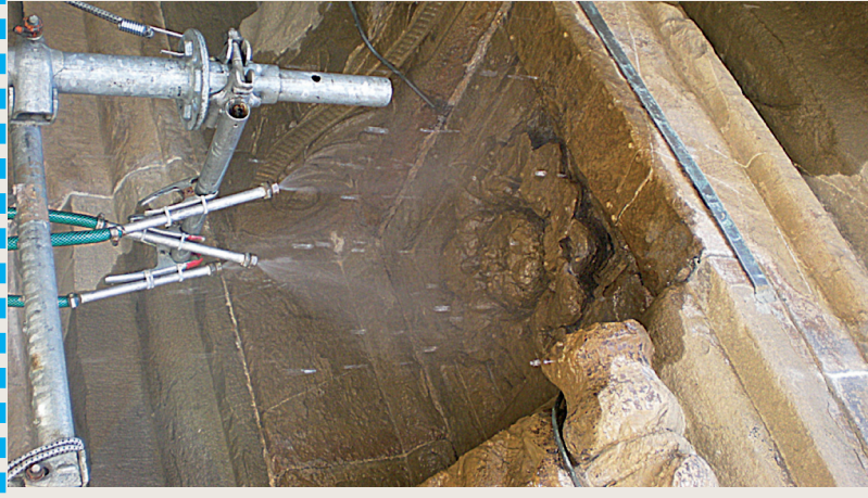
Dopo il preconsolidamento, e la rimozione dei depositi di polvere e delle piccole scaglie decese con pennelli e spazzole in setola morbida e con aspiratori, si è proceduto alla pittura della superficie con acqua nebulizzata a bassa pressione.
