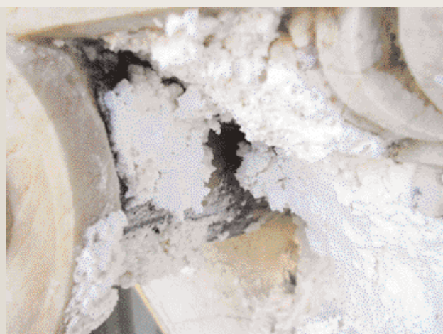
Fase di stesura della polpa di cellulosa sui depositi superficiali.
