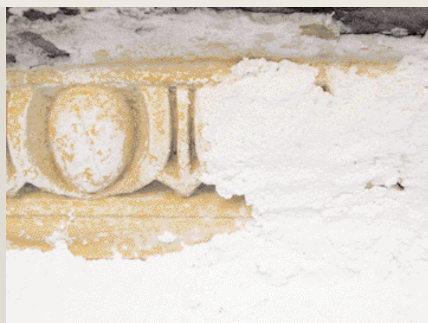
Impacco di polpa di cellulosa e carbonato di ammonio su intonaco finito a marmorino successivamente tinteggiato di giallo.
