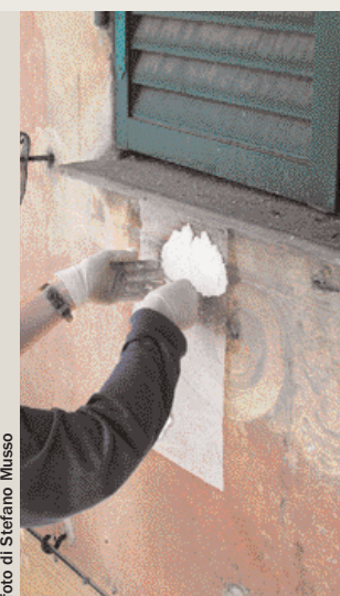
Intonaco decorato a secco. Velinatura della superficie e stesura della polpa di cellulosa imbevuta di carbonato di ammonio e prove di pulitura.
