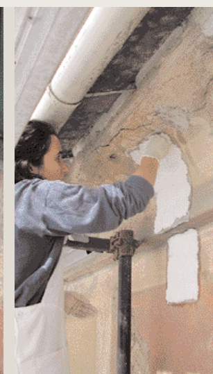
Fase di rimozione dell'impacco di polpa di cellulosa steso su carta giapponese.
