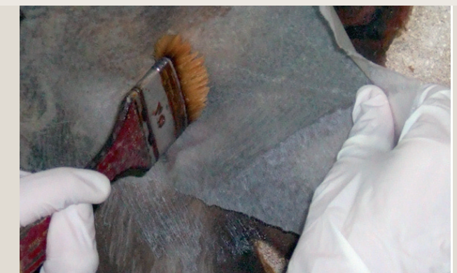
Applicazione di carta giapponese su intonaco affrescato, preliminare all'operazione di consolidamento.
