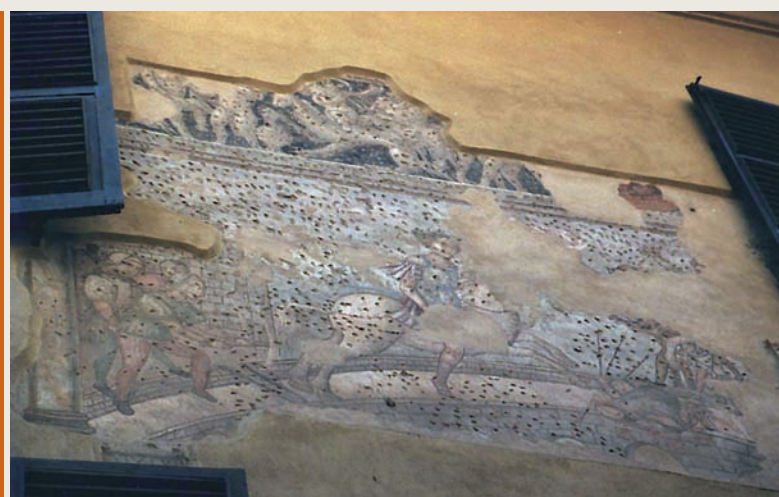
Novi Ligure, palazzo della Biblioteca civica, esempio di lacuna «creata» appositamente per mettere in evidenza l'apparato decorativo esistente al di sotto dell'intonaco attuale. Si evidenzia il trattamento a «tinta neutra» delle mancanze dell'affresco ritrovato.
