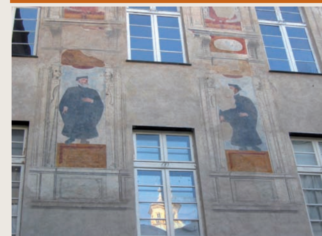
Genova, Piazza delle Vigne, Palazzo di Agostino Doria, intervento su una facciata dipinta con la tecnica della «tinta neutra» con riproposizione della decorazione architettonica solo dove rimanevano le incisioni d'intonaco.
