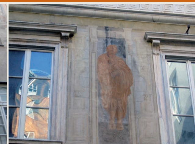
Genova, Piazza delle Vigne, Palazzo di Domenico Grillo, particolare della facciata dipinta trattata con la tecnica del sottotono, riproponendo sia la decorazione architettonica sia quella figurativa.
