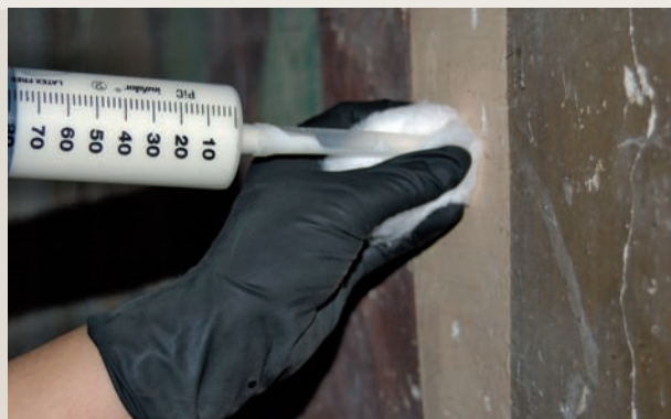
Iniezione di caseinato di calcio mediante siringa e cono di applicazione.
