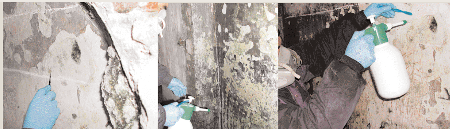
2. (a) Pulitura con il bisturi di tinte in fase di distacco; (b) applicazione con lo spruzzatore manuale di acqua deionizzata dopo la pulitura con il bisturi; (c) l'azione emolliente del liquido viene integrata dalla blanda azione meccanica di uno spazzolino con setole morbide di nylon.
