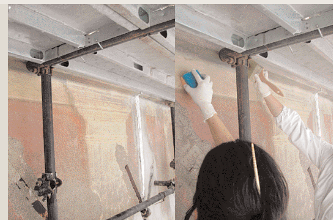
3. (a) Superficie policroma, decorata caratterizzata da un degrado da deposito superficiale poco coerente; (b) prove di pulitura «a secco» con pennello e spugna wishab.
