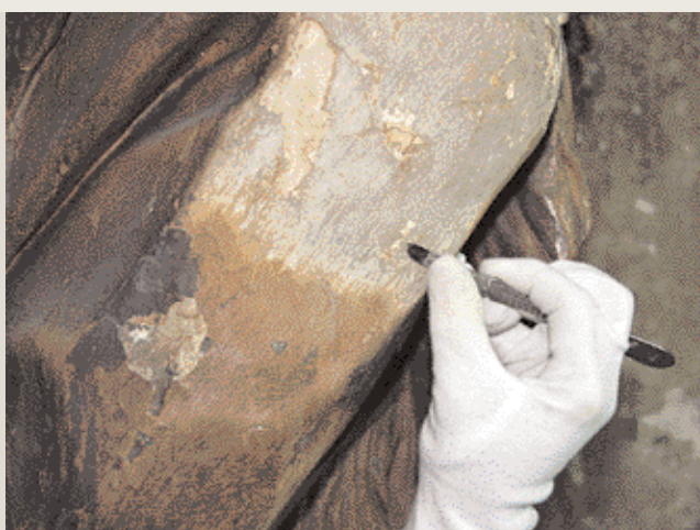
5. Eliminazione di una scialbatura mediante bisturi. Si noti la posizione della lama del bisturi posta parallelamente alla superficie.
