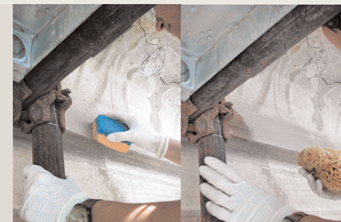
4. (a) Prova di pulitura di un cornicione dipinto con una spugna Wishab; (b) prova di pulitura della stessa superficie con una spugna di mare naturale.
