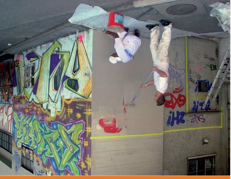
Frequentemente si tenta di «nascondere» le scritte vandaliche coprendole in modo più o meno efficace con uno strato di pittura.
