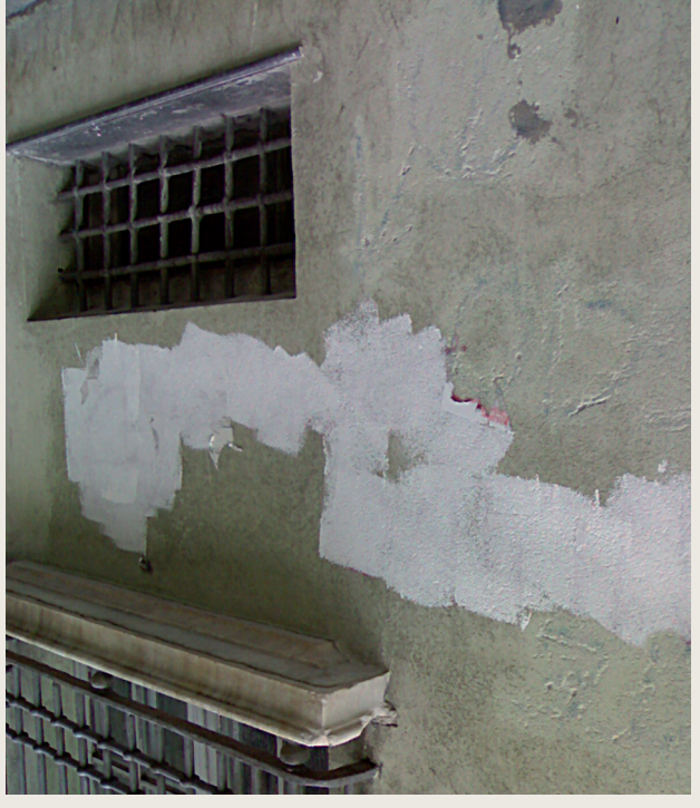
Frequentemente si tenta di «nascondere» le scritte vandaliche coprendole in modo più o meno efficace con uno strato di pittura.
