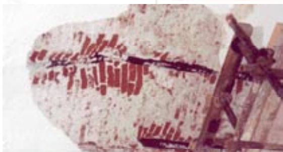
In basso dettaglio delle catene estradossali
