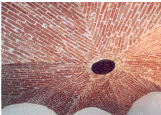
Sopra e a lato Volte di edifici genovesi
